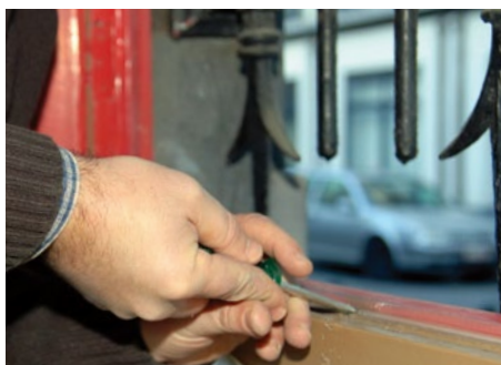
Débouchage des trous d'évacuation du bas du châssis.
