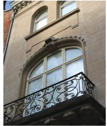
Châssis de conception actuelle dont l'extérieur reproduit l'aspect des châssis d'origine. Photo Frederic Hossey - AAC.
