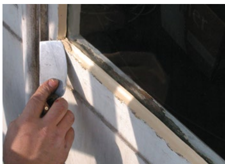
Remplacement d'un mastic endommagé.
