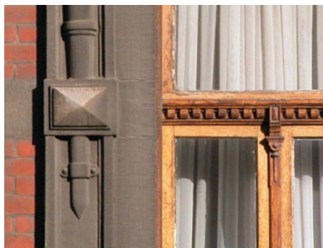
Fenêtre avec traverse ornementée, vers 1900. Avenue Brugmann 264, Uccle.
