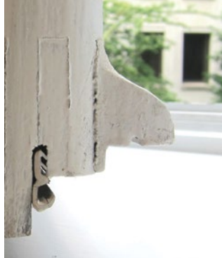
Joint souple posé par un menuisier.
