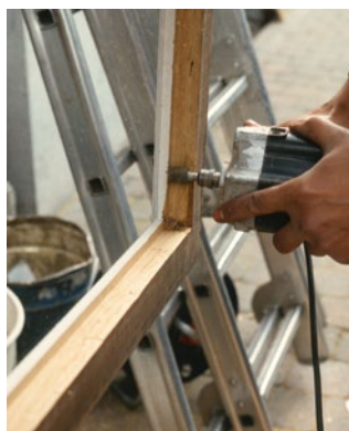
Pose de double vitrage avec élargissement de la feuillure à vitrage.
