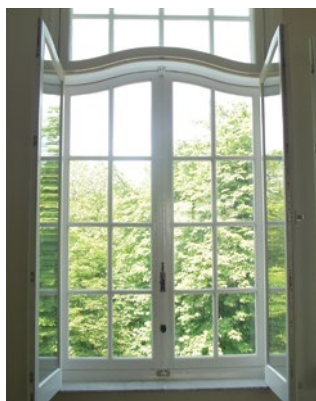
Pose d'une double fenêtre. Photo Paul Mordan.
