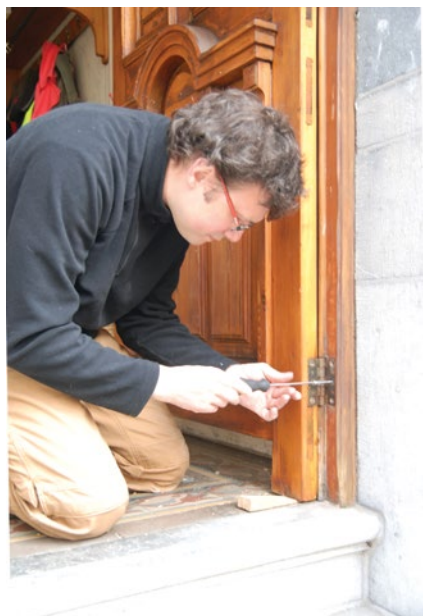
Repose de la porte après restauration.
