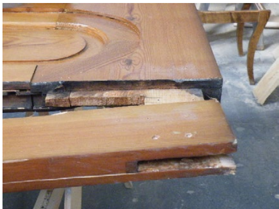
Démontage d'un montant à remplacer. Photo Olivier Cabay.
