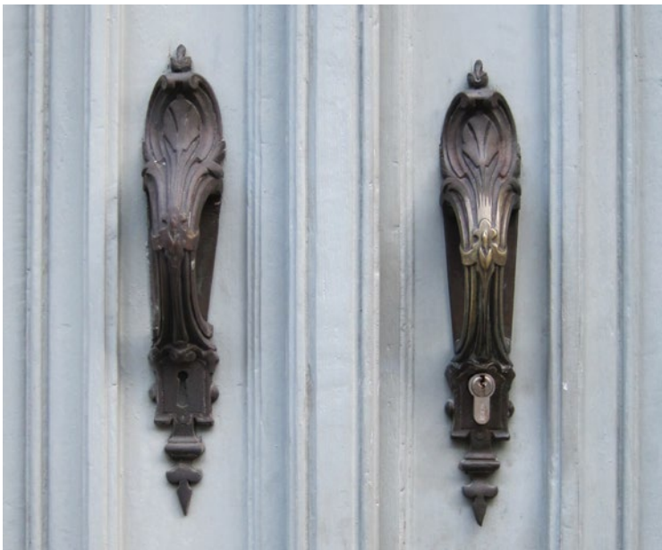
Garniture de serrure ancienne dont le trou de clé a été agrandi pour la pose d'un cylindre.
