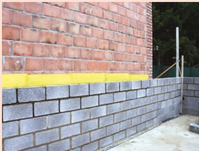
Dédoublage du mur mitoyen
