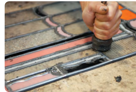
Aanbrengen van de voegkit onder de vleugels van de loodstrips ©J.-M. Gdalewitch
