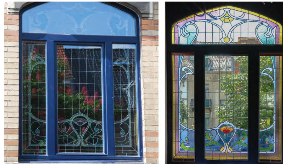
Het oorspronkelijke raam was onbruikbaar geworden. Het glas-in-loodraam werd via de binnenkant tegen het dubbel glas van het nieuwe raam geplaatst
