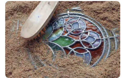
Reiniging met zaagsel om het teveel aan voegkit te verwijderen ©J.-M. Gdalewitch
