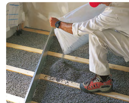
Mise en place de matériau absorbant en vrac © Thermofloc
