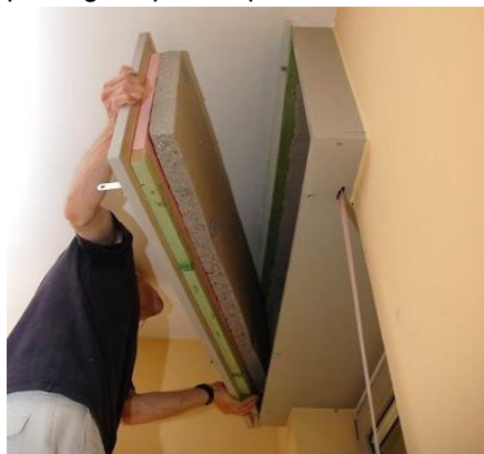
Figure 44 : Mise en œuvre
