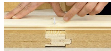
Plancher sur lambourdes flottantes © Steico
