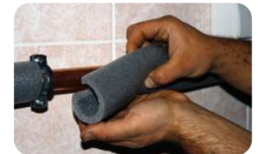
Placement d'une gaine en mousse
