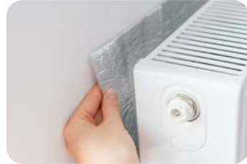
Installation d'un panneau réflecteur
