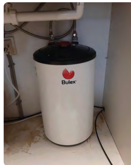
Ballon électrique de 15 litres à placer sous l'évier
