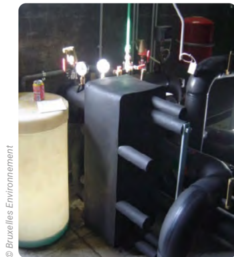
Échangeur à plaques isolé
