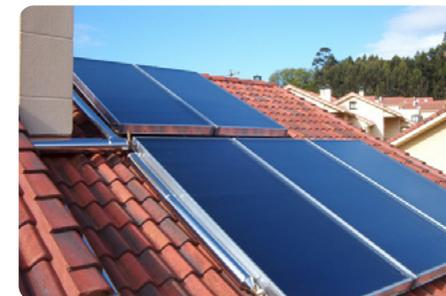
Les matériaux utilisés pour ces capteurs sont classiques, locaux (mines d'extraction en Europe), et facilement recyclables (cuivre, aluminium, inox, verre). Seul l'isolant est difficile à recycler car souvent composé de laine de roche qui peut résister à de hautes températures (jusqu'à 200°C dans les capteurs).
