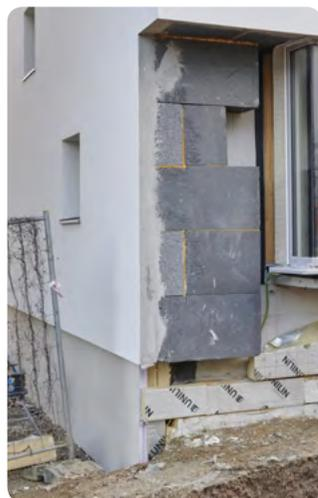
Enduit sur isolant EPS
