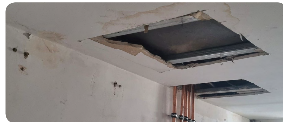
Faux-plafond existant en cours de travaux
