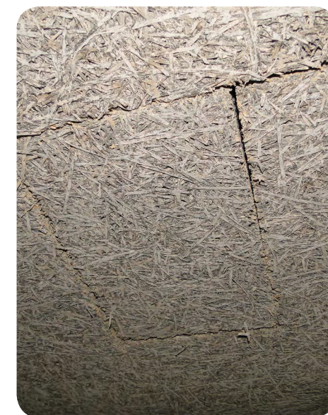
Un bouchon amovible découpé dans le panneau isolant a été réalisé pour permettre un accès à la vanne du réseau d'eau dans le panneau isolant © AGC
