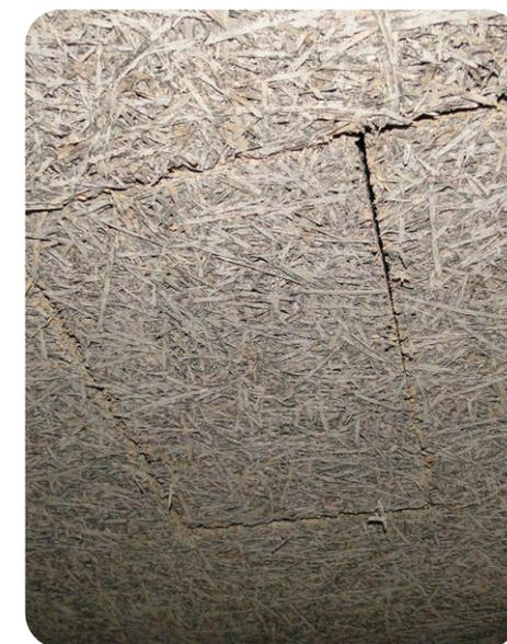
Un bouchon amovible réalisé dans le panneau isolant a été réalisé pour permettre un accès à la vanne du réseau d'eau dans le panneau isolant © AGC
