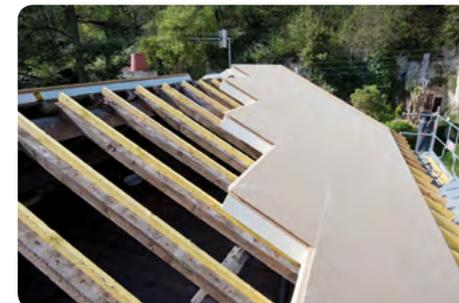
Pose de panneaux sandwich avec pare-vapeur, isolant et sous-toiture intégrés
