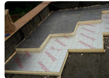
Pose de l'isolant sur l'étanchéité existante
