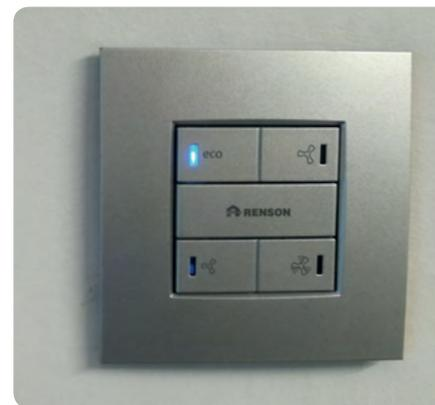
Régulation manuelle pour système C centralisé
