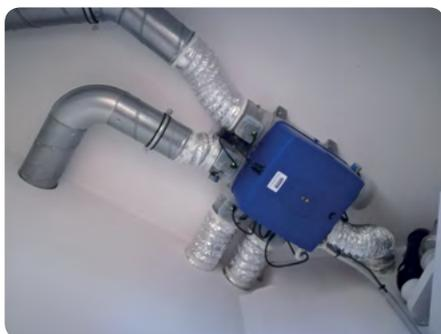
Extracteur pour l'évacuation mécanique en système C
