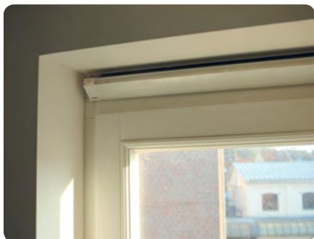
Amenée d'air via un aérateur placé entre le châssis et le linteau
