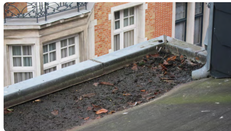
Rue de la Source 85, 1060 Saint-Gilles
