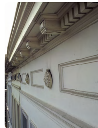
Modèle de couvercle de boulins Rue du Mont-Blanc 26, 1060 Saint-Gilles
