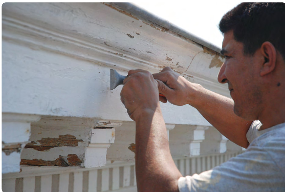
Préparation du support avant mise en peinture
