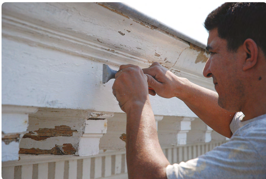
Préparation du support avant mise en peinture
