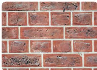
Briques de maçonnerie peintes avec joints beurrés retracés au fer
