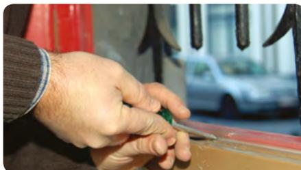
Débouchage des trous d'évacuation du bas du châssis
