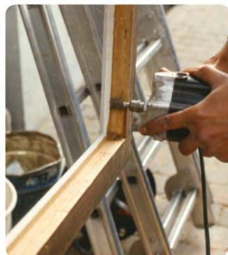
Pose de double vitrage avec élargissement de la feuillure à vitrage
