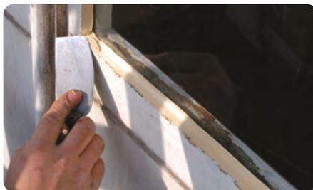
Remplacement d'un mastic endommagé
