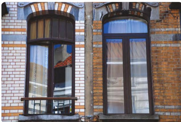
À gauche, la fenêtre d'origine. À droite un remplacement de châssis inadéquat : traverse placée trop haut, profilés trop larges, perte des petits bois et des verres colorés.
