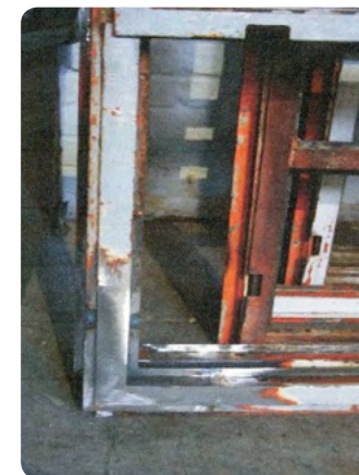
Greffe dans un dormant de châssis en acier ©Ferronnerie Dejeond-Delarge
