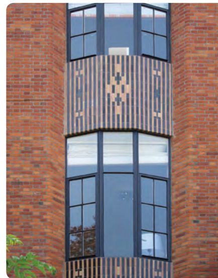
Châssis à deux ouvrants à petites divisions, Alfred Nyst Square Vergote 45, 1030 Schaerbeek (1922)
