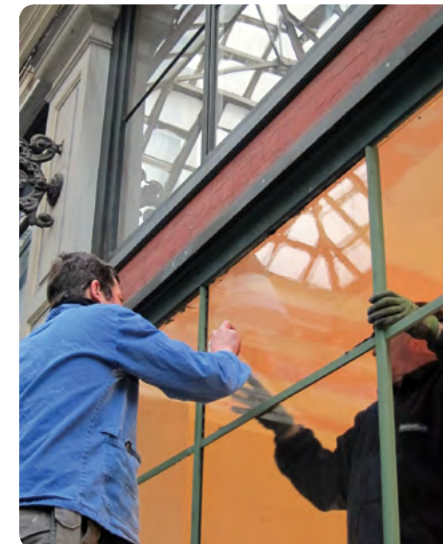
Pose de verre étiré à l'ancienne Galerie des Princes, 1000 Bruxelles
