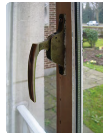
Pose de double vitrage dans le châssis existant © Michel Louis
