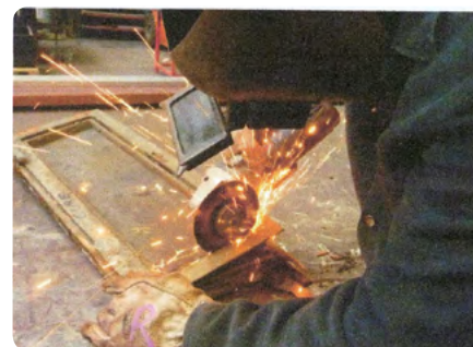
Dégagement de zones corrodées à la disqueuse © Ferronnerie Dejeond-Delarge
