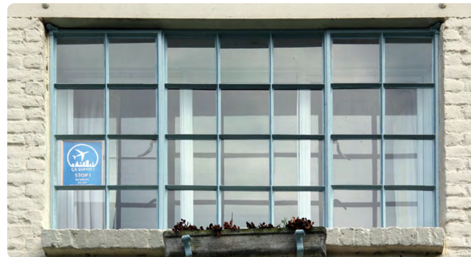
Pose d'une double fenêtre
