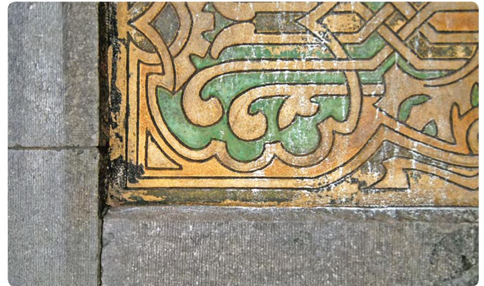
Le sgraffite qui allait être restauré par la suite n'a pas été protégé pendant le nettoyage de façade (technique du micro-grésage hydro-pneumatique : projection de granulats fins avec un peu d'eau). Il en résulte des traces de sable abrasif sur l'enduit qui a été également mouillé de manière excessive.
