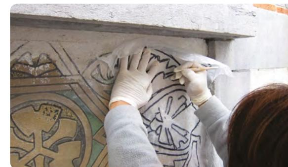
Report du motif dans l'enduit selon la technique du tracé appuyé à travers un calque
