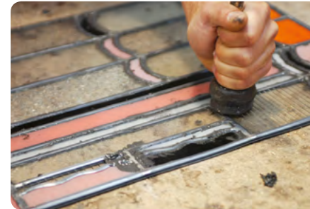
Insertion du mastic sous les ailes des baguettes de plomb ©J.-M. Gdalewitch
