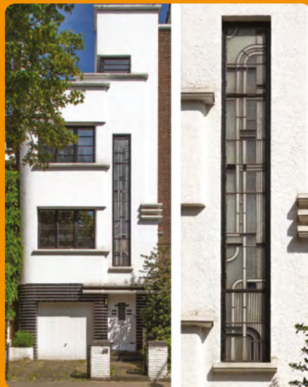
Le vitrail moderniste joue sur les textures et intervient dans la composition architecturale de la façade. Avenue Coghen 68, 1180 Uccle
