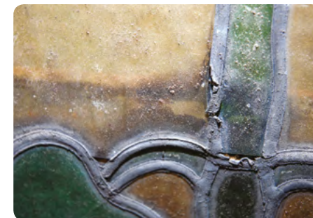
Altération des plombs © J.-M. Gdalewitch
