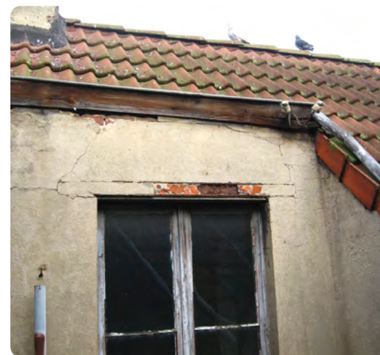
Façade, corniches et châssis en mauvais état ; toiture et descente d'eau pluviale « bricolée » : la sécurité et la salubrité font défaut.
