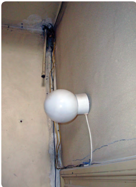
Installation électrique vétuste
