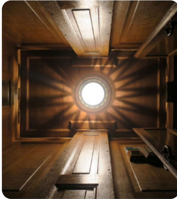
Adaptation du luminaire d'origine et intégration de l'éclairage de secours
