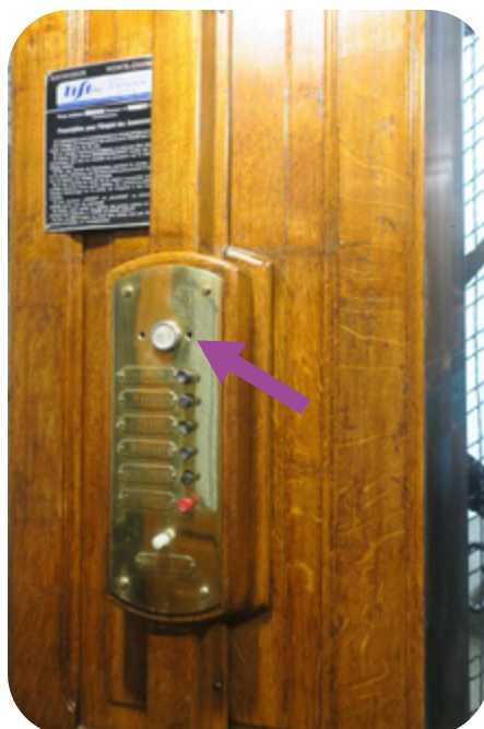
Communication bidirectionnelle reliée au bouton d'alarme du boîtier de commande d'origine
