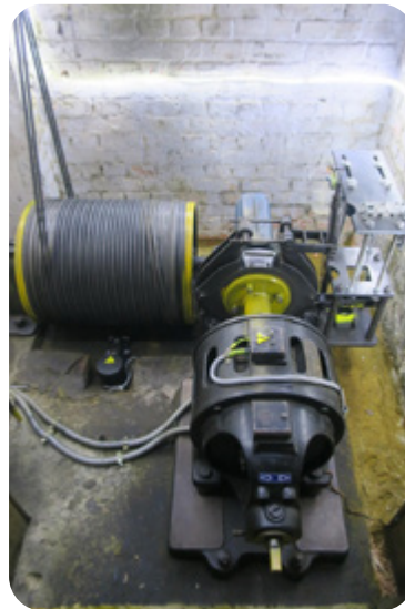
Rebobinage du moteur ancien
