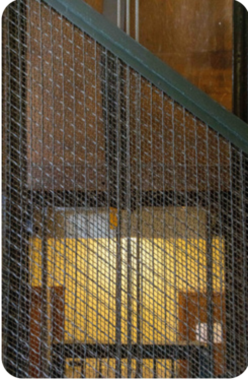
Doublage du treillis pour réduire la taille des mailles
