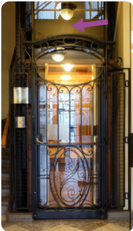
Ajout d'une imposte vitrée au-dessus des portes palières
