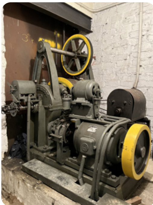
Mise en peinture du tambour à enroulement, de la poulie de déflexion et du volant de manœuvre manuelle
