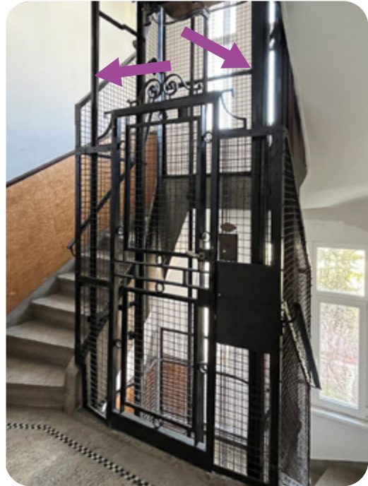
Rideaux de cellule posés aux angles de la face avant
