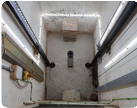
Installation dans la cuvette d'un amortisseur sous la cabine et de bandes LED
