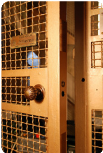
Serrure positive sur une porte palière battante vue de l'extérieur de la gaine
