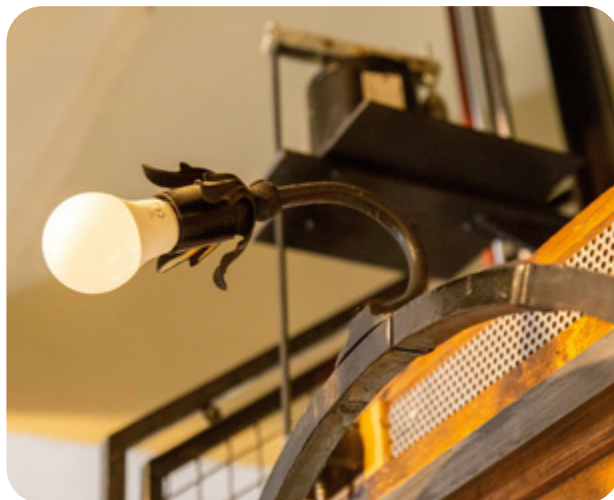
Applique en ferronnerie conservée dans laquelle est intégrée une nouvelle ampoule
