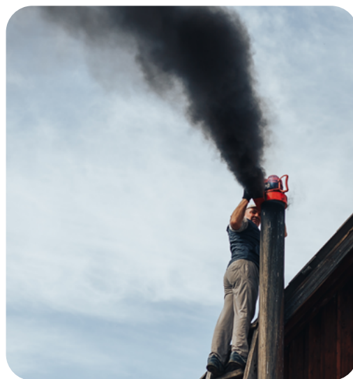
Nettoyage d'un conduit de cheminée
