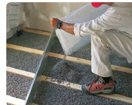
Plaatsing van los absorberend materiaal ©Thermofloc
