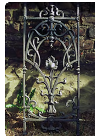
Decoratief gietijzeren element dat door een hedendaagse gieterij terug in productie werd gebracht
