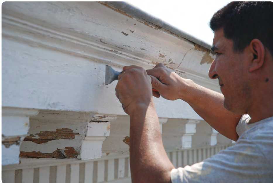
Vorbereiding van de ondergrond vóór het schilderen
