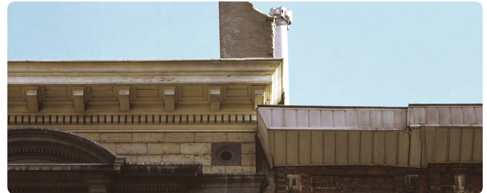
Daklijst bedekt met PVC latten © Verz. AAM
