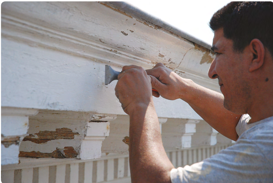
Voorbereiding van de ondergrond vóór het schilderen
