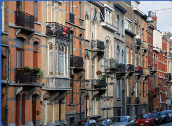
De Brusselse bebouwing wordt gekenmerkt door een grote verscheidenheid aan gevelmaterialen Madeliefjesstraat, 1030 Schaarbeek
