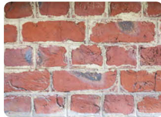
Hetzelfde type parement na een niet aangepaste reiniging
