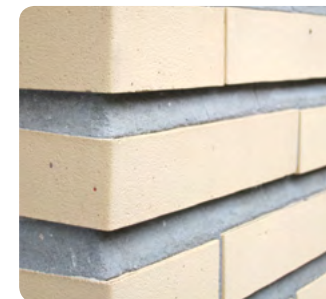
Afgeschuinde voegen die de schaduwen versterken in een bakstenen parement van de jaren 30
