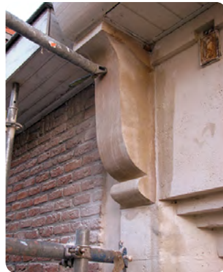
Vervanging van een beschadigde console © Richard Thomas
