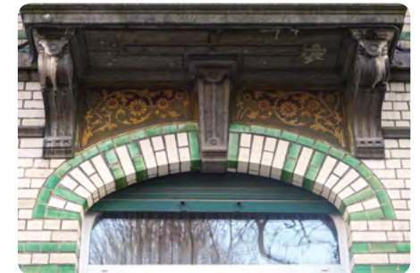
Groene verglaasde baksteen en witte gladde baksteen Eedgenotenstraat 77, Brussel
