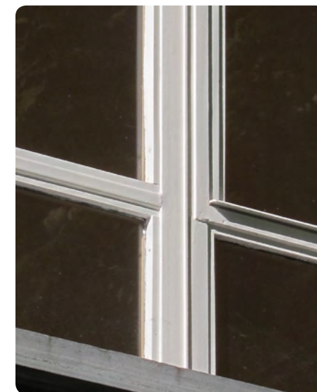
Stalen raam in een gebouw van de jaren 1950 Dageraadstraat 1a, 1050 Elsene
