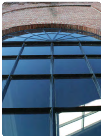
Enkel glas met lage emissie in een stalen raam met kleine verdelingen © Van Ruysdael
