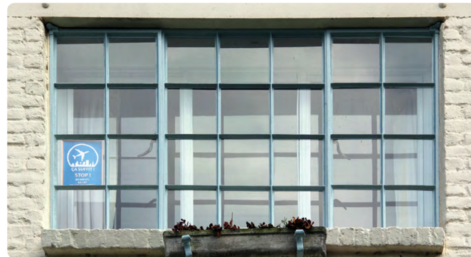
Plaatsing van een dubbel venster
