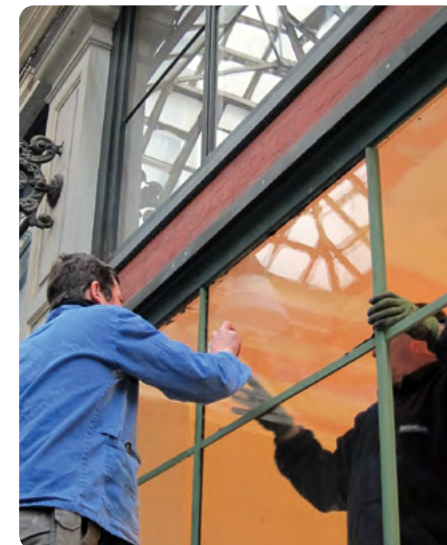
Plaatsing van getrokken glas op traditionele wijze Prinsengalerij, 1000 Brussel
