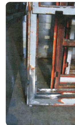
Herstellen van elementen in het kozijn van een stalen raam © Ferronnerie Dejeond-Delarge
