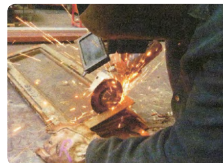
Blootleggen van de aangetaste zones met de slijpschijf © Ferronnerie Dejeond-Delarge
