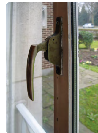
Plaatsing van dubbel glas in het bestaande stalen raam © Michel Louis
