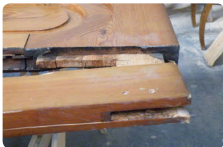
Demontage van een te vervangen stijl © Olivier Cabay
