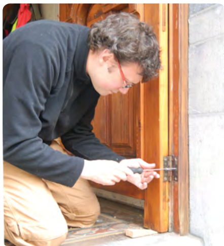
Terugplaatsing van de deur na restauratie
