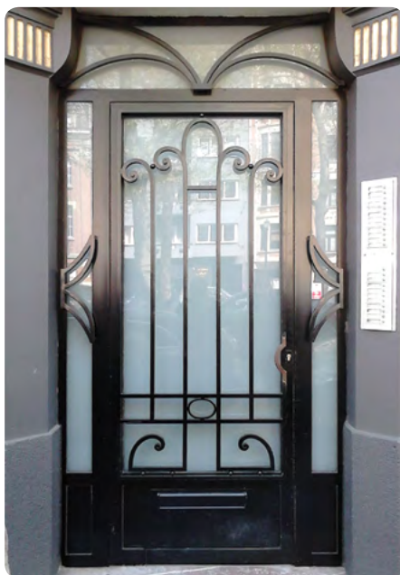
Nieuwe deur met integratie van een element van de oorspronkelijke deur en met respect voor de gevelstijl (1922) Handelskaai 23, 1000 Brussel
