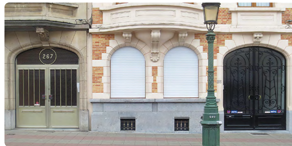
Vervanging van deur die de stijl van het gebouw en de stedenbouwkundige voorschriften niet respecteert
