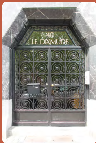
Deur in art deco (1925) Diksmuidelaan 40, 1000 Brussel
