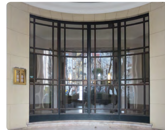
Modernistische deur in staal (1936) Mauricelaan 31, 1050 Elsene
