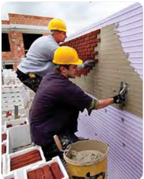
Steenstrips gelijmd op isolatie © Livios Sto
