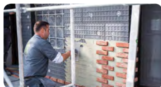
Steenstrips gelijmd op isolatie © Ecococon
