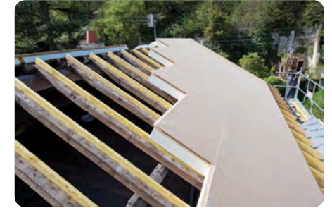
Plaatsing van sandwichpanelen met geïntegreerd dampscherm, isolatie en onderdak © Unilin Insulation
