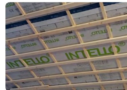
Plaatsing van dampscherm onder de isolatie © Isoproc
