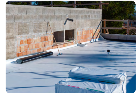
Plaatsing van het EPDM-membraan
