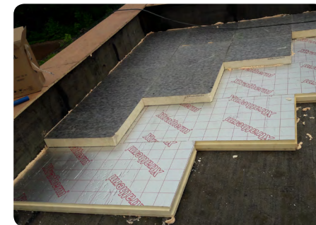
Plaatsing van isolatie op de bestaande afdichting
