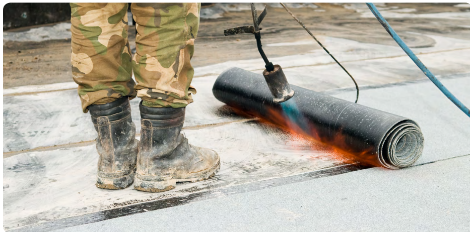
Verlijming van bitumineuze lagen door vlamlassen
