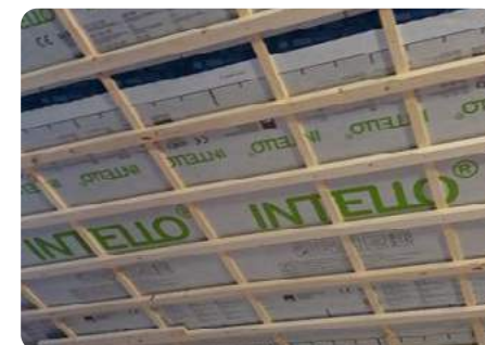
Plaatsing van dampscherm onder de isolatie © Isoproc
