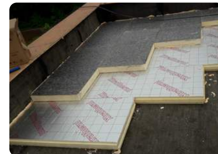
Plaatsing van isolatie op de bestaande afdichting
