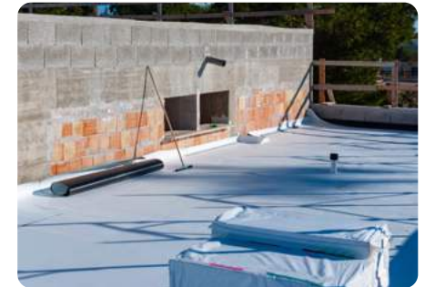
Plaatsing van het EPDM-membraan
