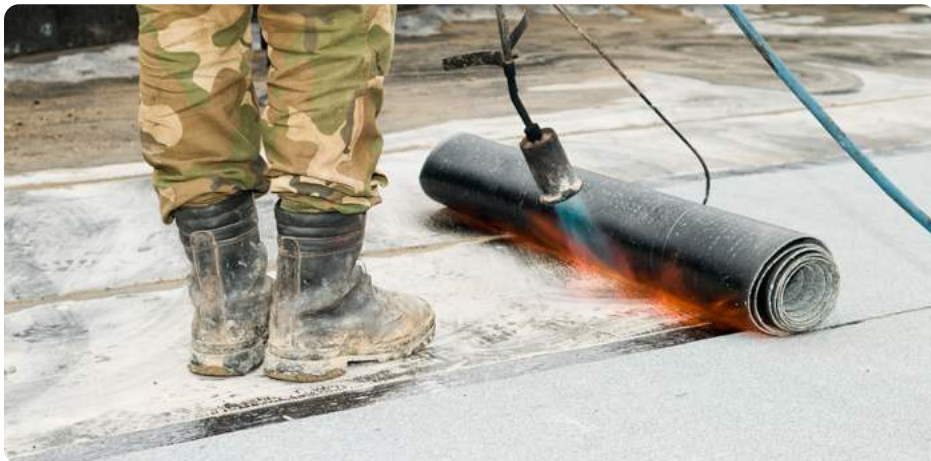
Verlijming van bitumineuze lagen door vlamlassen
