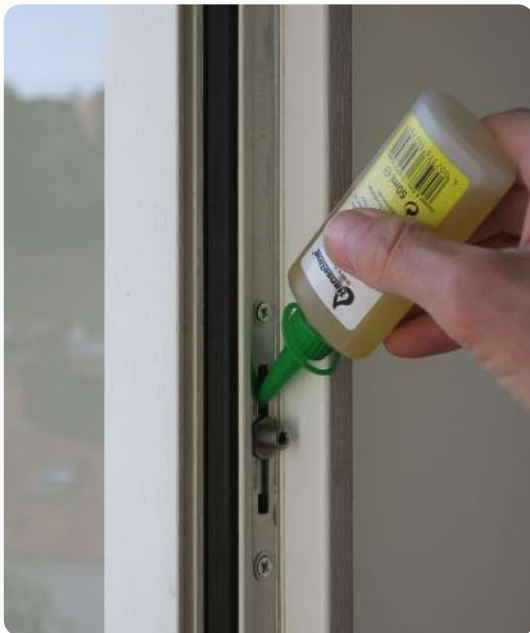
Het hang- en sluitwerk moet één keer per jaar gesmeerd worden.
