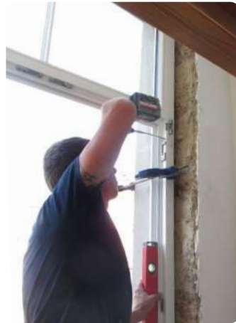
Voor de plaatsing van een raam is een hoge mate van precisie van de plaatsers vereist.
