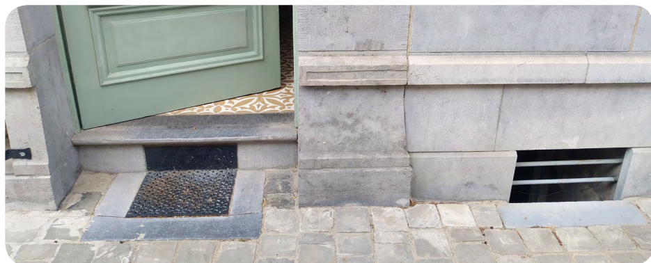
Kelderraam en opening voor een goede ventilatie
