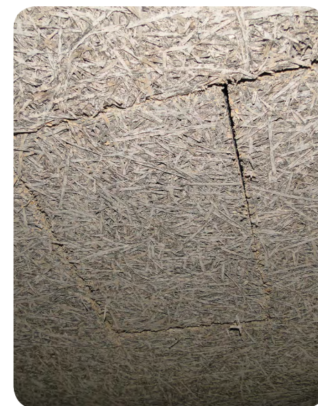
Er is een verwijderbare plug uit het isolatiepaneel gesneden om toegang te krijgen tot de kraan van het waternetwerk in het isolatiepaneel © AGC
