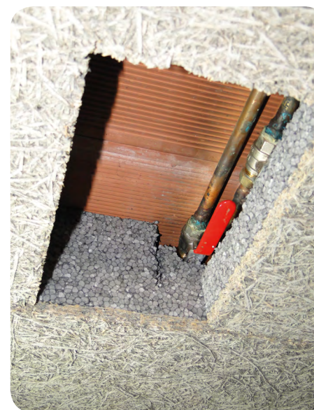
Er is een verwijderbare plug uit het isolatiepaneel gesneden om toegang te krijgen tot de kraan van het waternetwerk in het isolatiepaneel © AGC
