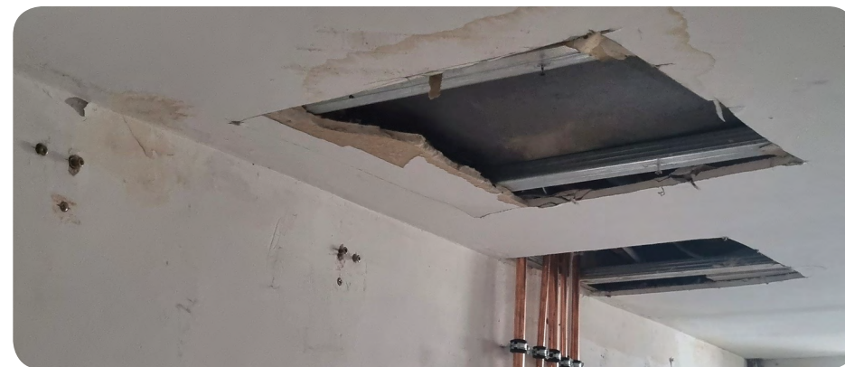
Bestaand verlaagd plafond tijdens de werkzaamheden
