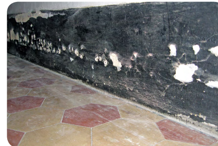
Opstijgend vocht aan de voet van een muur met afbladderende verf
