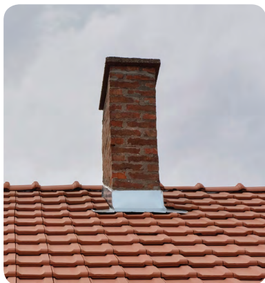
Gootstukken bij de aansluitingen met de dakpannen
