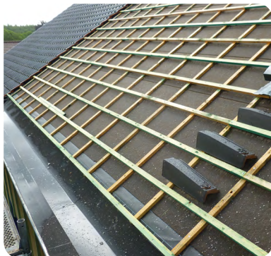
Onderdakfolie geplaatst onder de dakpannen © Isopro
