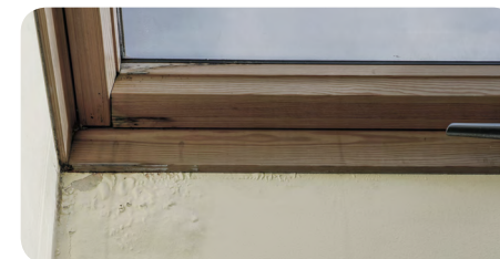
Blaasvorming van de verf op de omlijsting van een dakvenster door een slechte verbinding tussen het raam en het hellende dak
