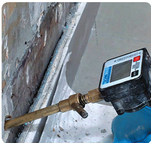
Injecties met hydrofoob product tegen opstijgend vocht in een kelderwand © Technichem
