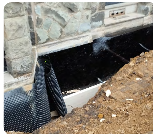
Waterdichtingsmembraan op bestaande muur tegen de grond
