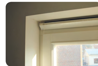
Ventilatierooster ingebouwd in het raam voor luchttoevoer naar droge ruimtes
