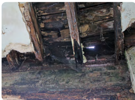
Ontwikkeling van zwammen in de platformstructuur als gevolg van infiltraties
