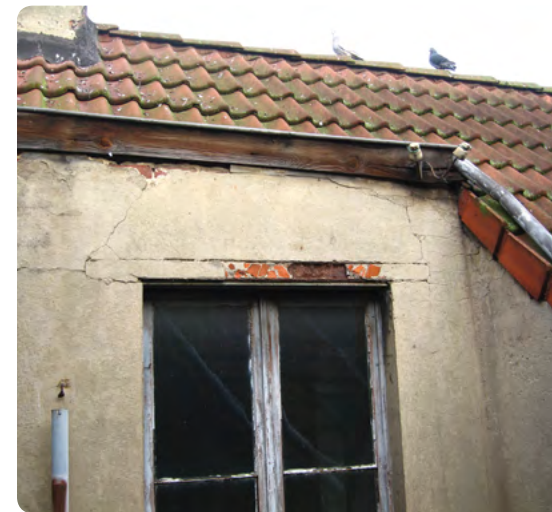
Gevel, daklijsten en ramen in slechte staat; "in elkaar geknutseld" dak en regenwaterpijp: veiligheid en gezondheid ontbreken
