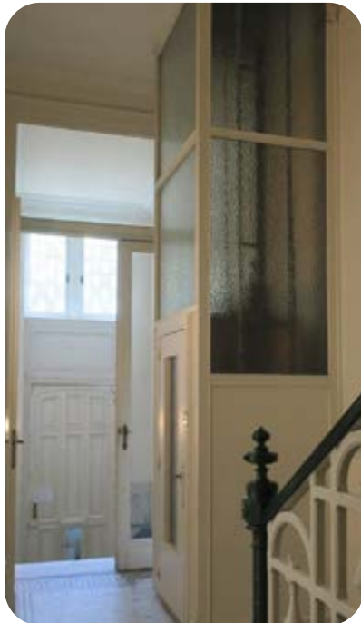
Beschermingsfolie over de glazen wanden van de gesloten schacht
