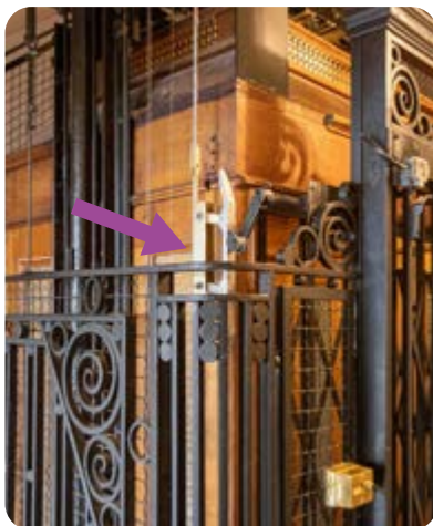
Mobiele schaats uitgeklaapt op de benedenverdieping
