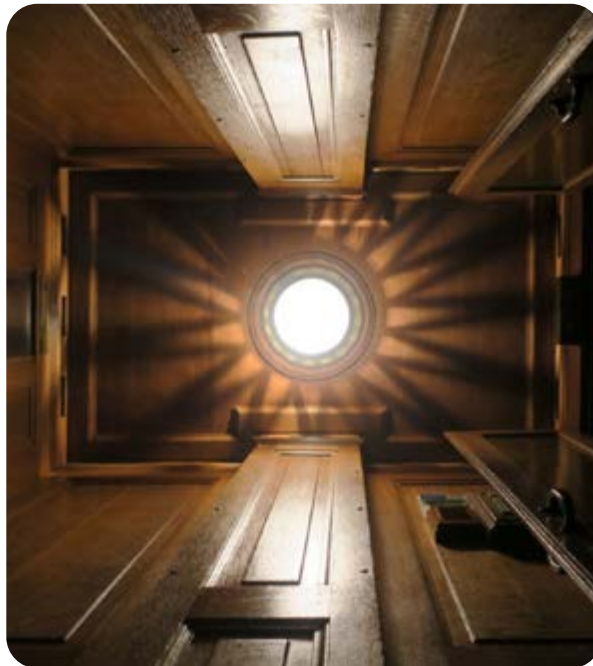
Aanpassing van de oorspronkelijke plafondlamp en integratie van de noodverlichting
