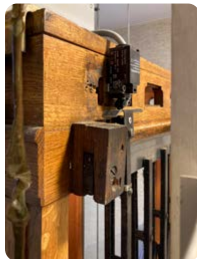
Veiligheidscontact op een houten vouwhek
