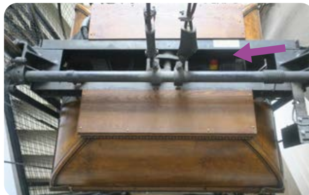
Integratie van de inspectiebesturing in het koidak
