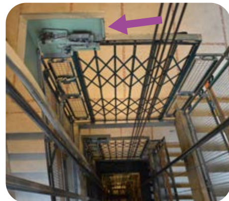
Beveiliging van het ontgrendelingsysteem, uitvoering op maat
