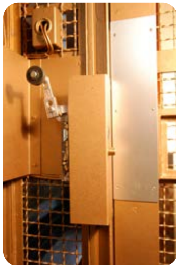
Positieve vergrendeling op een vleugel deur van een bordes gezien van binnen de schacht
