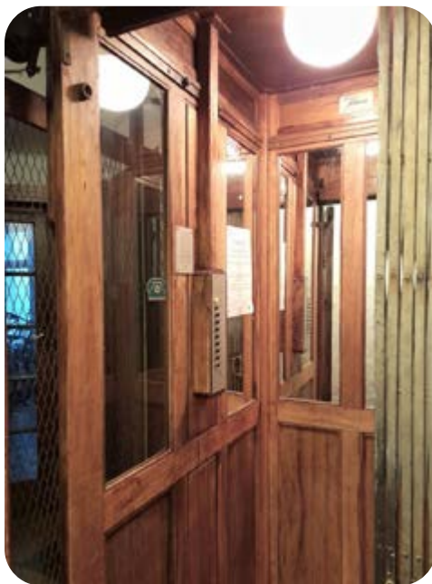
Beschermingsfolie op het glaswerk
