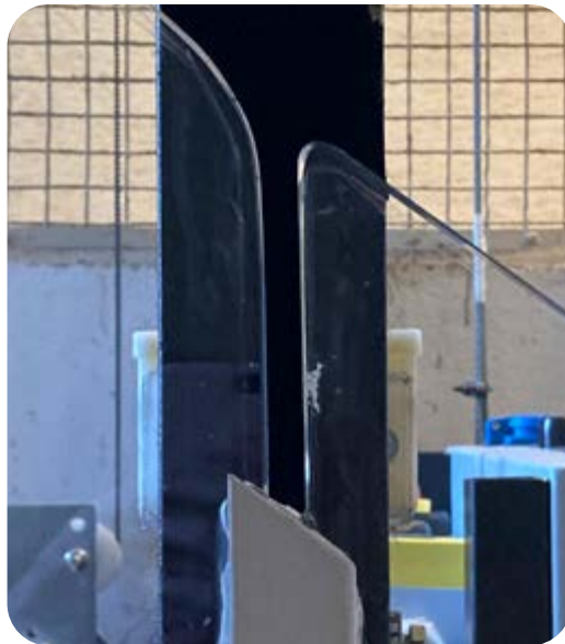
Beschermingsfolie over het glazen deel van de schachtbescherming
