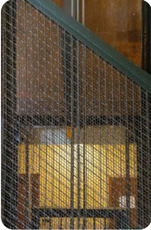
Verdubbeling van het vlechtwerk om maaswijdte te verkleinen
