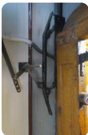
Mobiele schaats uitgeklaapt op de vereiste verdieping
