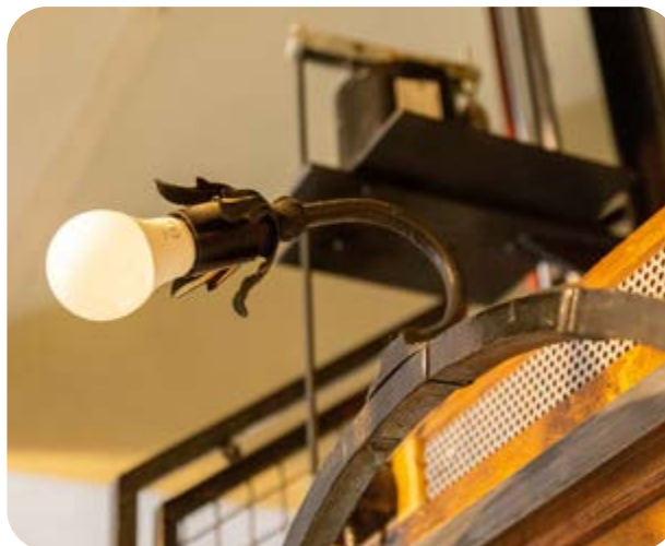
Wandlamp in smeedijzerwerk die werd behouden en waarin een nieuwe lamp werd geplaatst
