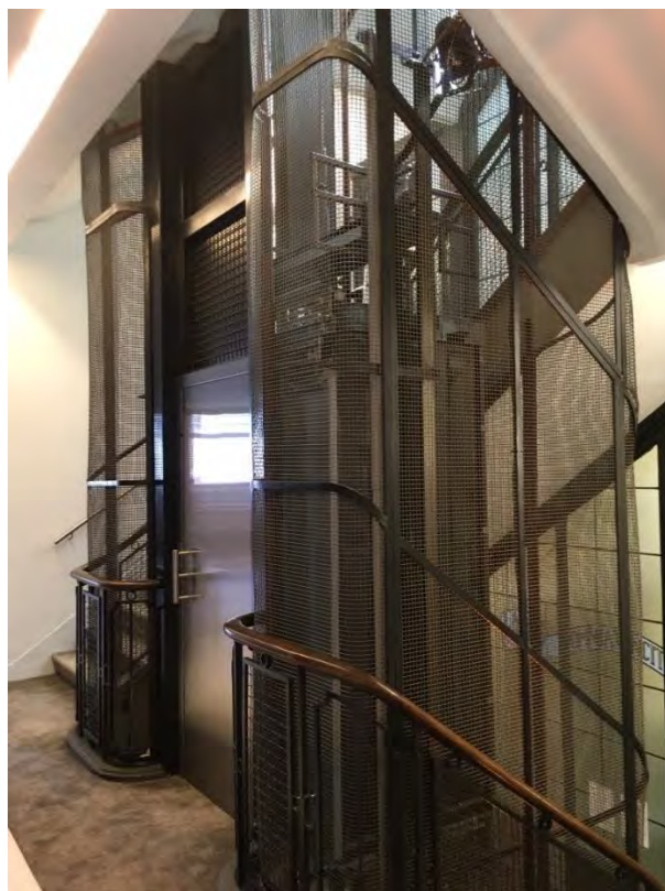
Afsluiting van de schacht met een fijnmazig traliewerk, nieuwe schachtdeur
