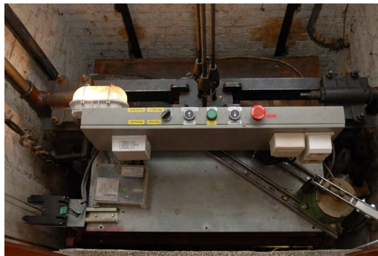
Inspectiekast op het koidak
