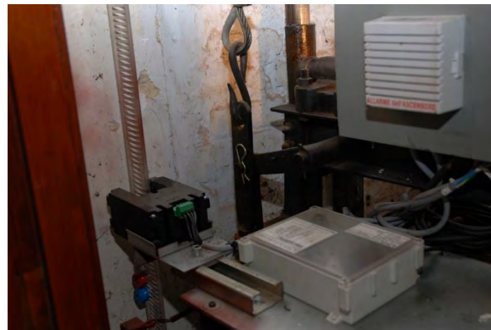
Voorbeeld van een nieuw vloerselectiesysteem
