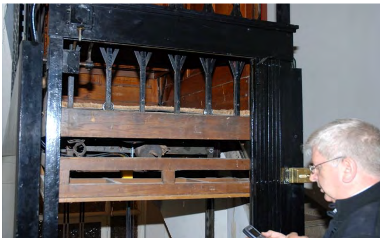
Oud beveiligingssysteem onder de vloer van de kooi
