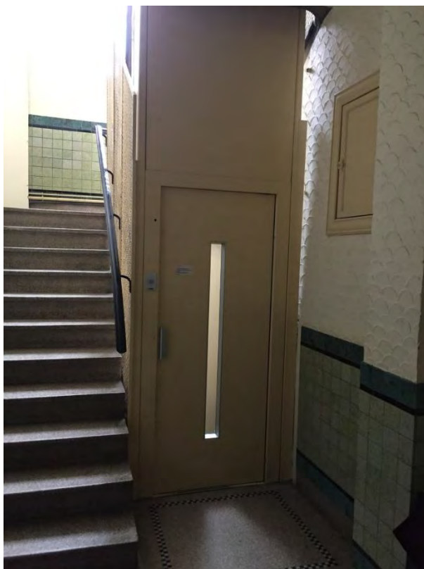
Het sluiten van de voorkant van de schacht met een paneel en nieuwe bordesdeur
