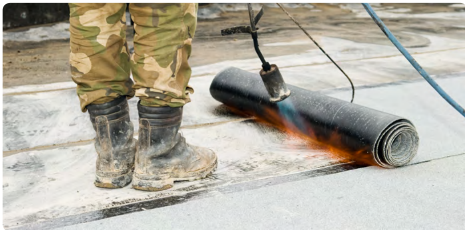
Collage des couches bitumeuses par soudage à la flamme
