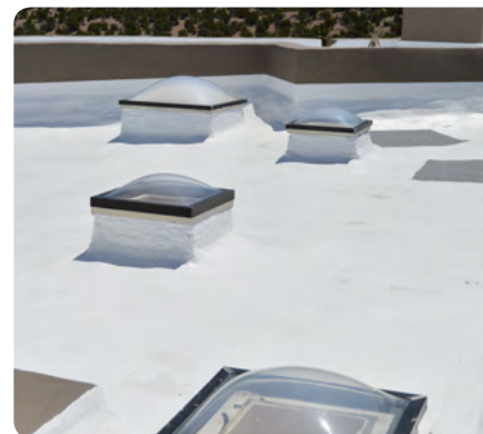
Étanchéité recouverte d'une peinture réfléchissante
