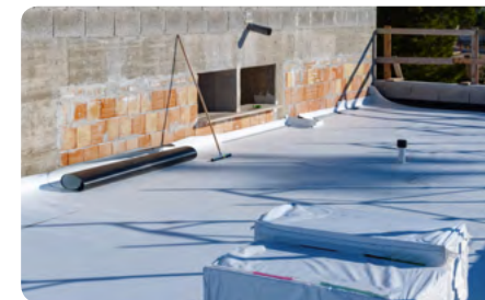
Mise en œuvre d'une membrane en EPDM
