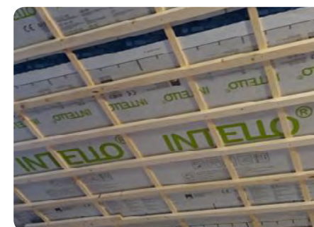
Pare-vapeur sous l'isolant © Isoproc
