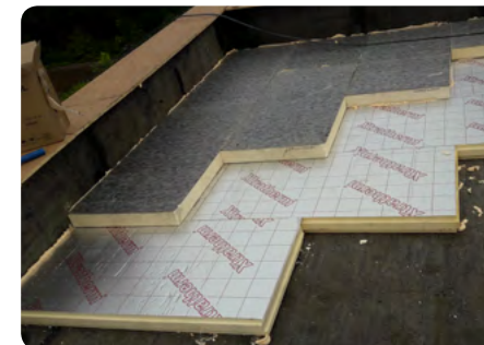
Plaatsing van isolatie op de bestaande afdichting
