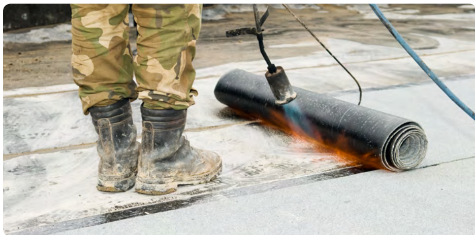
Verlijming van bitumineuze lagen door vlamlassen
