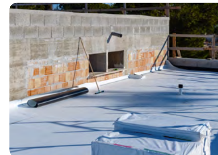
Plaatsing van het EPDM-membraan
