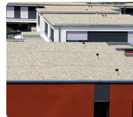
Afdichting beschermd door een lichtgekleurde ballastlaag
