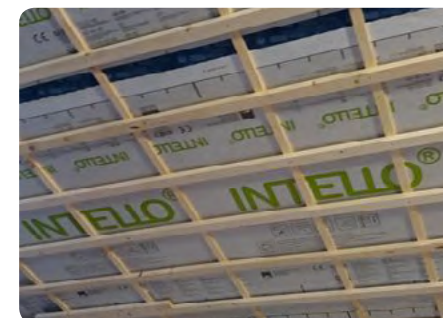
Plaatsing van dampscherm onder de isolatie © Isoproc
