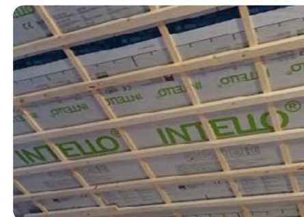
Pare-vapeur sous l'isolant © Isoproc
