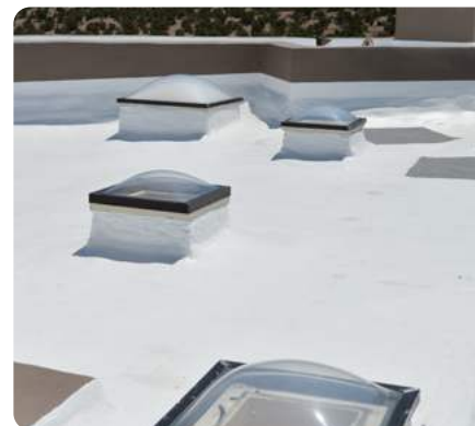
Étanchéité recouverte d'une peinture réfléchissante
