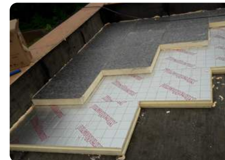
Pose de l'isolant sur l'étanchéité existante
