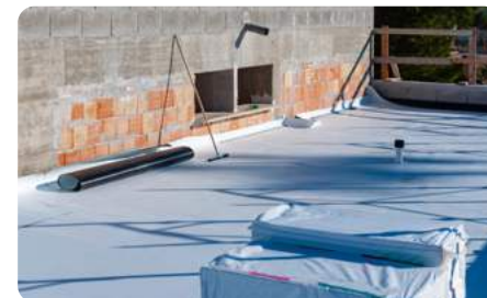
Mise en œuvre d'une membrane en EPDM
