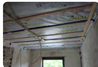
Dampscherm onder de vloer © samennele.blogspot
