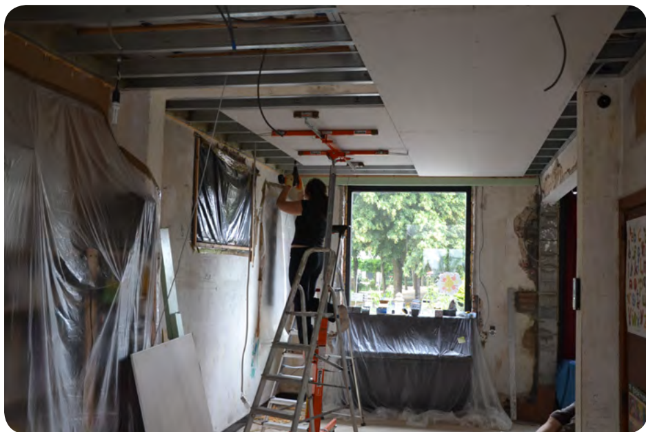
Plafondafwerking onder de structuur © samennele.blogspot
