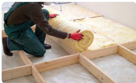
Soepele isolatie in een houtstructuur
