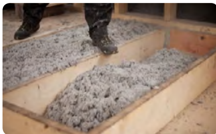
Losse isolatie in een hulpconstructie
