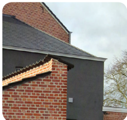
Sommet du mur à versant unique, marque de non-mitoyenneté, le mur est privatif au propriétaire B sauf acte contraire
