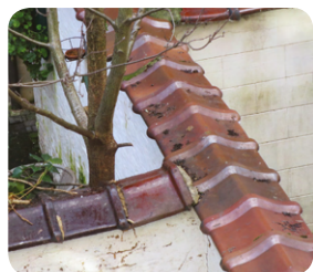
Les murs de séparation entre cours et jardins sont présumés mitoyens
