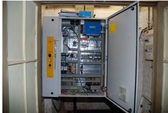
Nouvelle armoire de commande (Atelier Marien)
