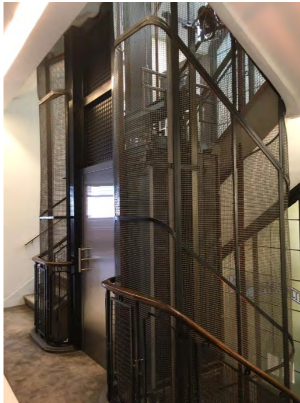
Fermeture de la gaine à l'aide d'un treillis métallique à fines mailles, nouvelle porte palière
