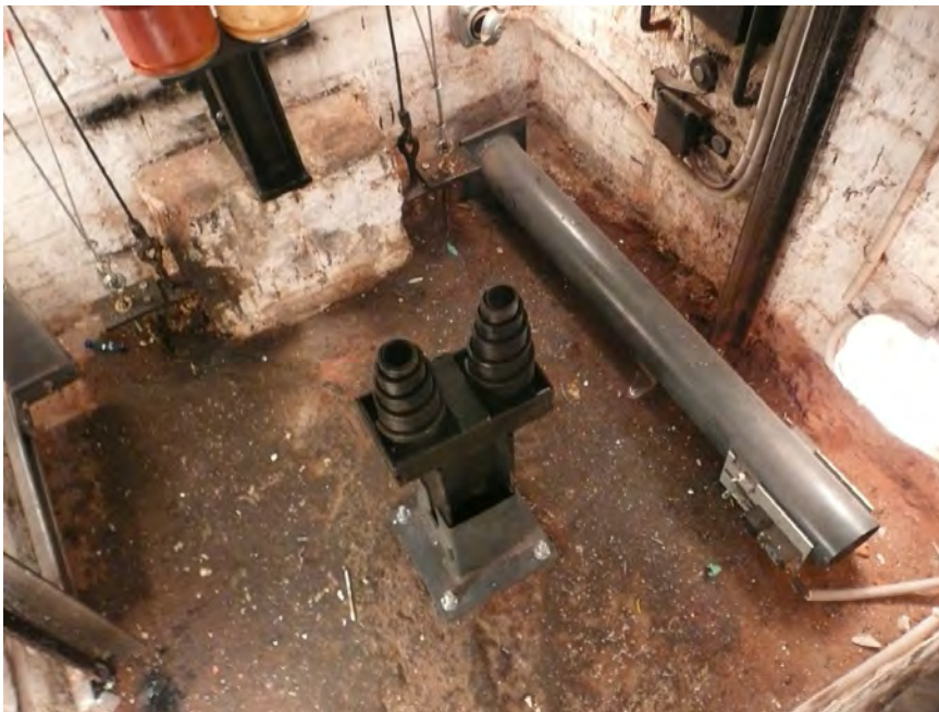
Installation d'un système d'arrêt de la cabine en fond de trémie
