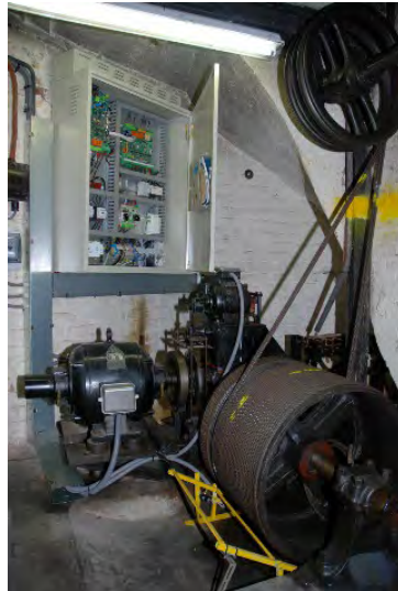
Nouvelle armoire de commande (Atelier Marien)
