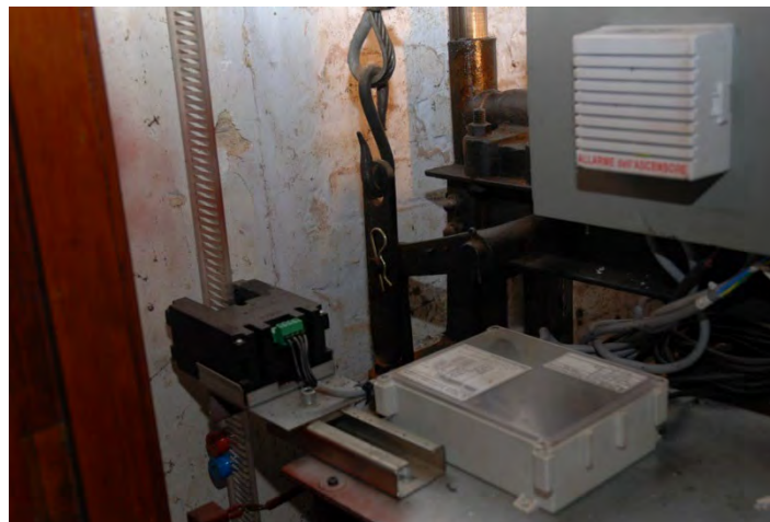
Exemple de nouveau système de sélection d'étage
