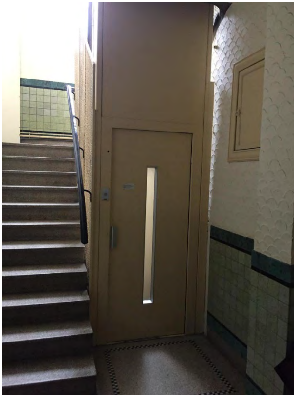
Fermeture de la face avant de la gaine à l'aide d'un panneau et nouvelle porte palière
