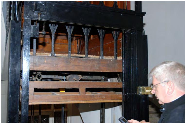
Dispositif de sécurité d'origine sous le plancher de la cabine
